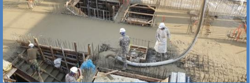
[ 내한 콘크리트 동절기 시공 ]
